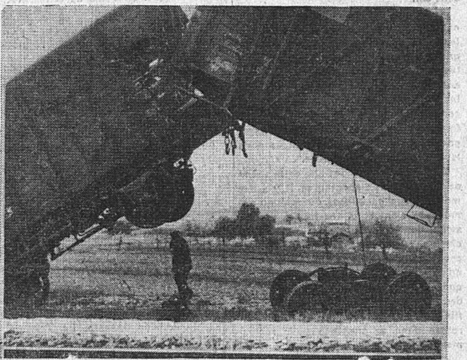
Par suite d'une erreur d'aiguillage, un train chargé de matériel a déraillé en gare de Longjumeau. La locomotive est tombée dans un fossé et plusieurs wagons sont montés les uns sur les autres. Il n'y a pas eu d'accident de personne, mais les dégâts sont importants.
