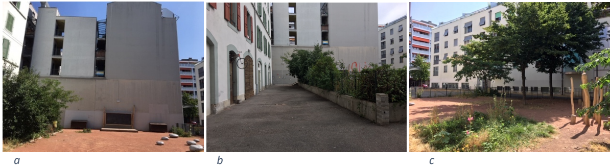
Figure 12: a) Le mur pignon sur le square Royaume pourrait être végétalisé avec des plantes grimpantes indigènes telles que de la vigne vierge, du lierre, des clématites. Cela apporterait un cadre plus agréable. b) La courette en contrebas pourrait être peinte avec des jeux au sol. c) L'espace central pourrait recevoir plus de jeux.
