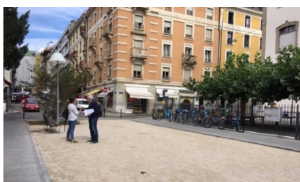
Figure 6: Exemple de revêtement de sol perméable installé par la Ville de Genève sur la rue de Zurich
